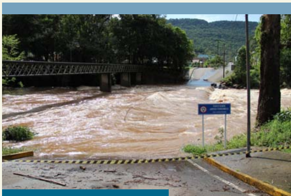
Vista parcial de enchente do arroio Forromeco, em São Vendelino (RS), em 19.09.2012.
